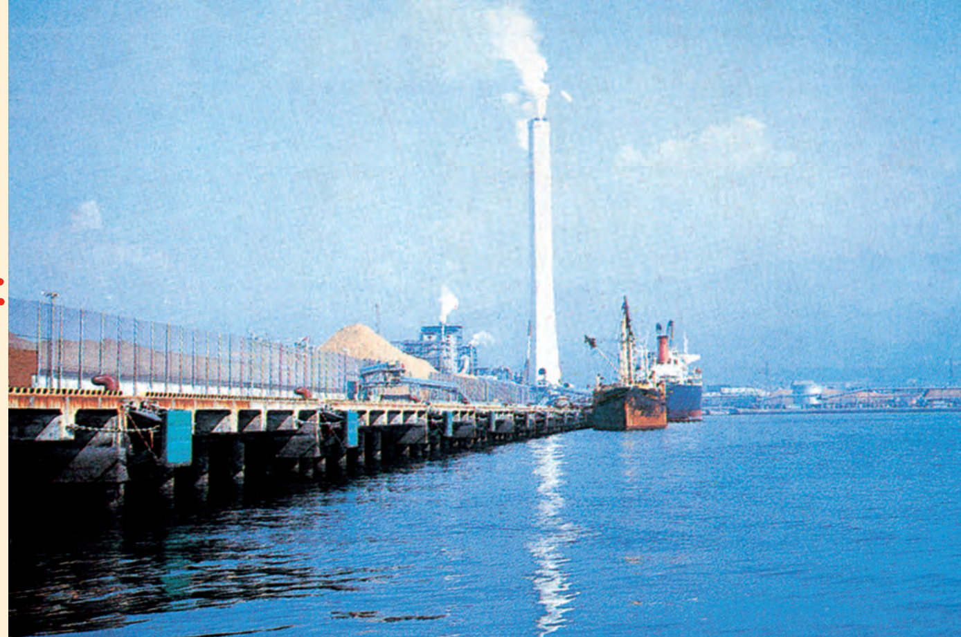
三島港10万TON岸壁(ユニット型防舷材)1400H×24基、エリエールタワーFRP煙筒
